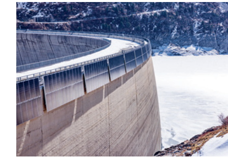
Photovoltaikanlage auf der Staumauer des Lago di Lei.
